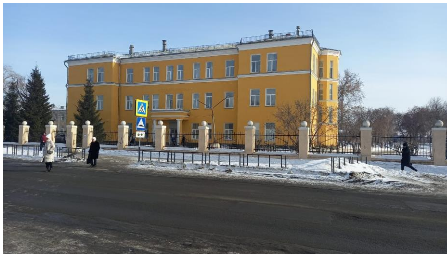
Фотография 66. Ремонт фасада ГБУ «ГБ №1 г. Копейск»
