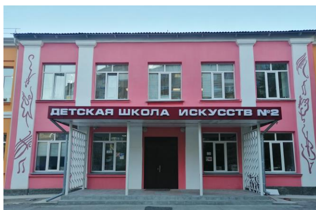
Ремонт фасад МУ ДО «ДШИ № 2»
