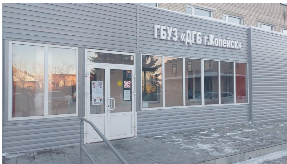
Фотография 71. Капитальный ремонт входной группы здания стационара в п. Потанино
