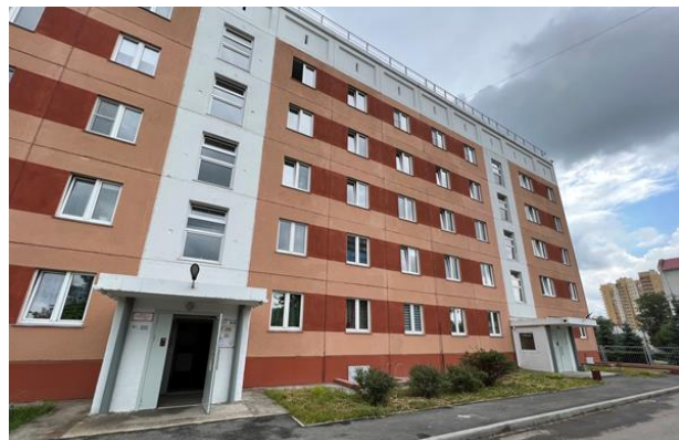
МКД по ул. Борьбы, 43
