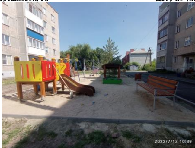
Двор по ул. Черняховского, 19 Фотографии 12-18
