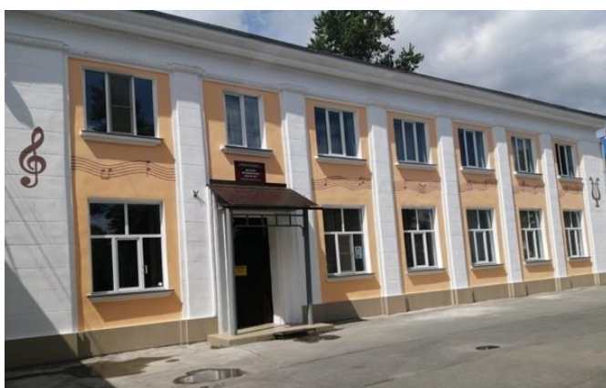
Ремонт фасада МУ ДО «ДМШ № 1»
