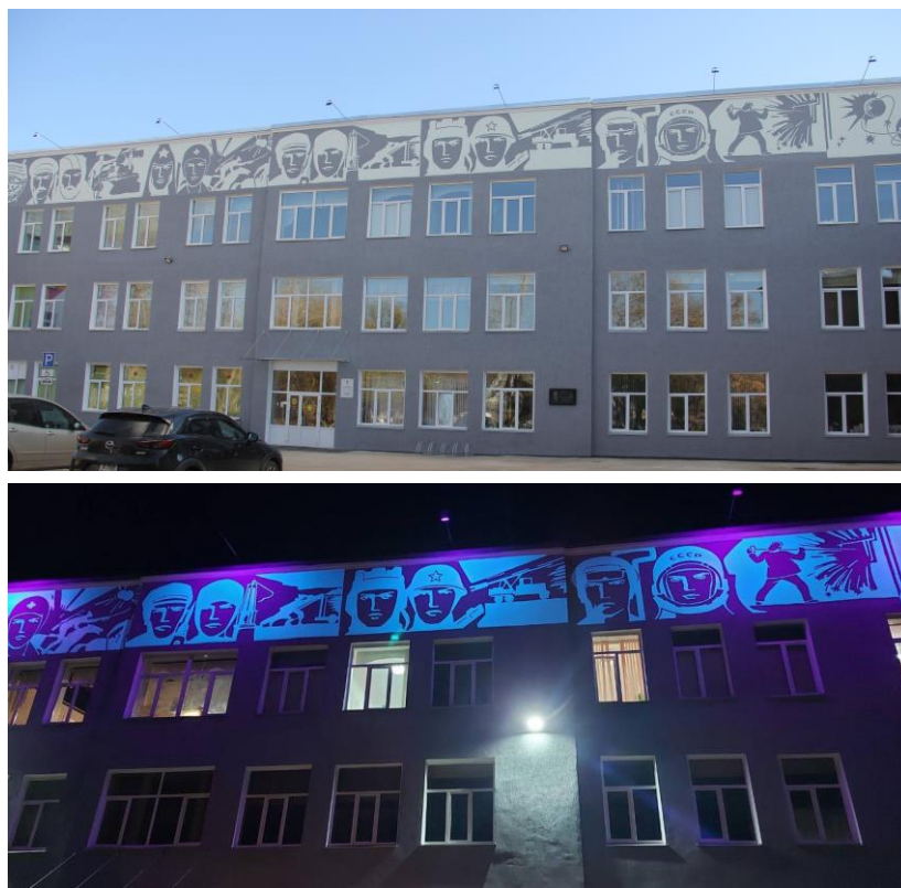
Фотографии 53-54. Капитальный ремонт фасада ДК «Угольщиков»
